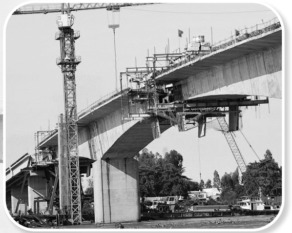
Cầu Châu Đốc thi công vượt tiến độ, dự kiến hợp long vào cuối tháng 12-2023 Ảnh: TÔNG DOANH
